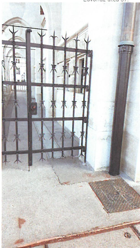
3. ábra – Az Országház DNy-i sarkán lévő tetőlefolyó csatlakozása a meglévő rácsos folyókába
