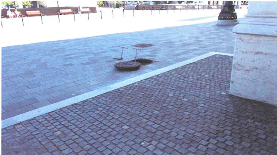
6. ábra - Az ÉNY-i oldalon a XVII. kapu előtt kiépült DN400 PVC-U gerinccsatorna tisztítóaknái
